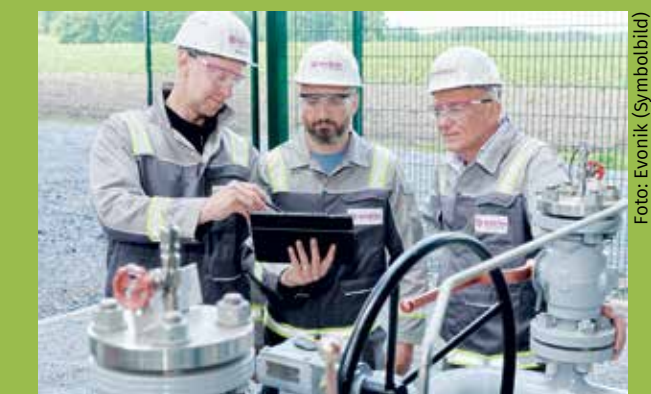
Besser gemacht: Präziser als per Handarbeit regelt nun eine Automatik die Zulauftemperatur in einer Raffinatanlage.
